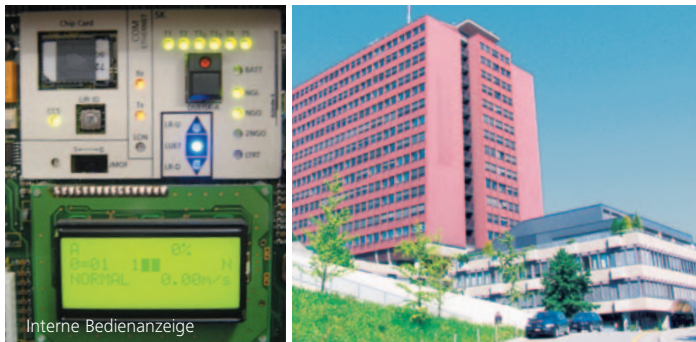
Steuerung und Umformer
