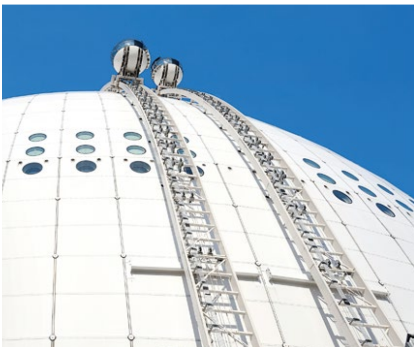
Immer an der Wand lang Außenaufzug an der Fassade der Veranstaltungshalle Globen in Stockholm
