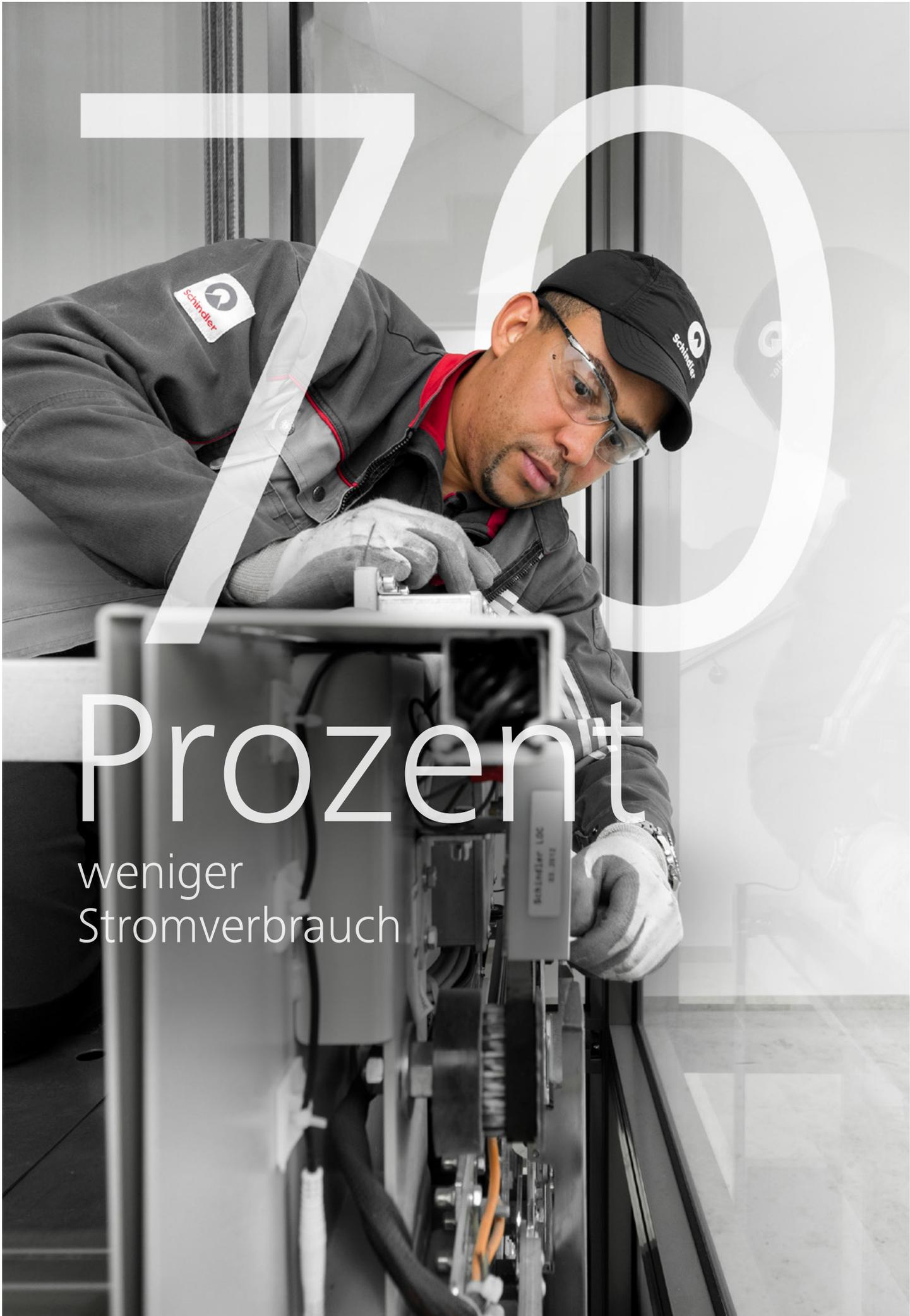
Der Aufzug ist seit jeher ein **Elektromobil**. Besonders energiesparend wird der Betrieb durch den Einsatz der KERS-Technologie für die Aufzugsanlage. Schindler KERS senkt den Stromverbrauch deutlich und ist eine Maßnahme zum energieeffizienten Gebäudebetrieb. Die Energieeffizienzklasse des Aufzugs kann dadurch gesteigert werden; **Energieverbrauch und -kosten sinken**.
